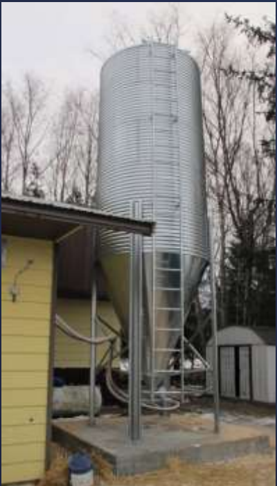
Haines pellet silo
